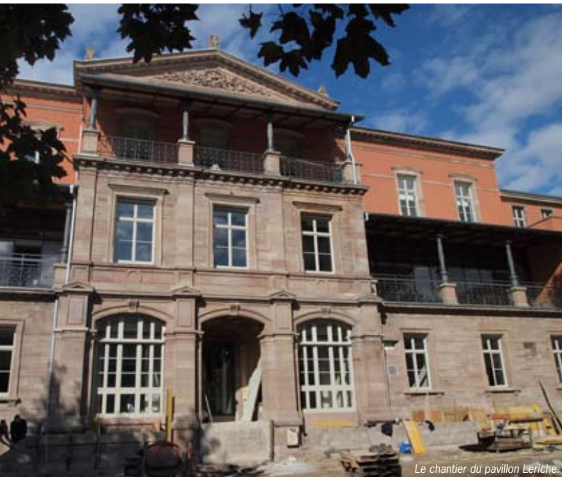
Le chantier du pavillon Leriche.
